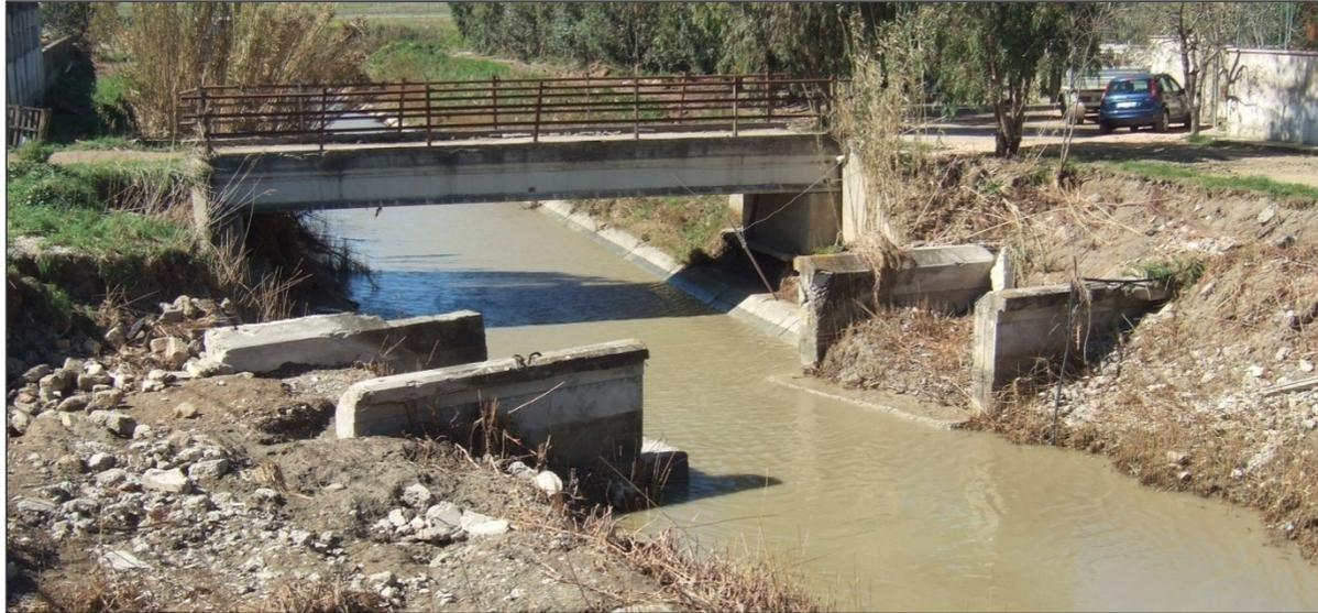
**Figura 14: Vista delle spalle del vecchio attraversamento situato lungo il collettore della Marinella in corrispondenza dell' immissione nel torrente Galaso**
