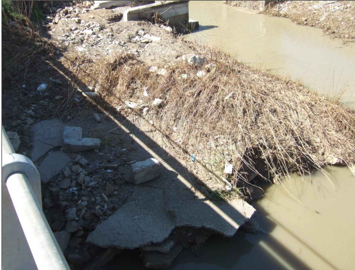
**Figura 12: Vista di un particolare della sponda destra idraulica della confluenza del collettore della Marinella nel torrente Galaso con la presenza di depositi di sedimenti e di materiale vario trascinato dalla corrente**
