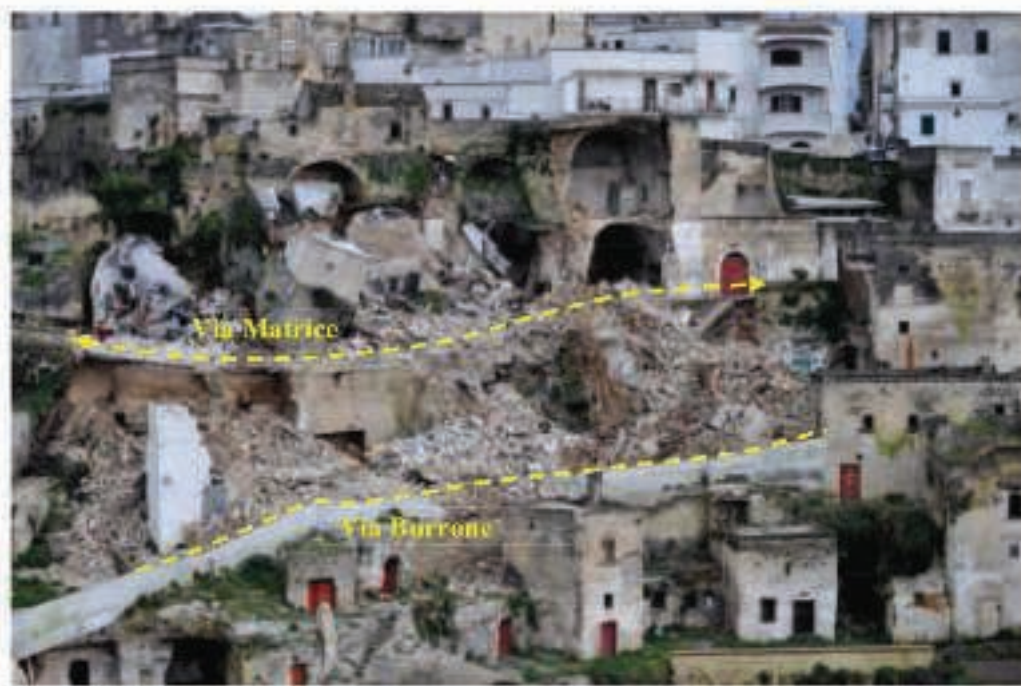
Figura 1 - Panoramica dell'area interessata dal fenomeno di crollo che il 21/01/2014 ha coinvolto le abitazioni di via Matrice e via Burrone.
