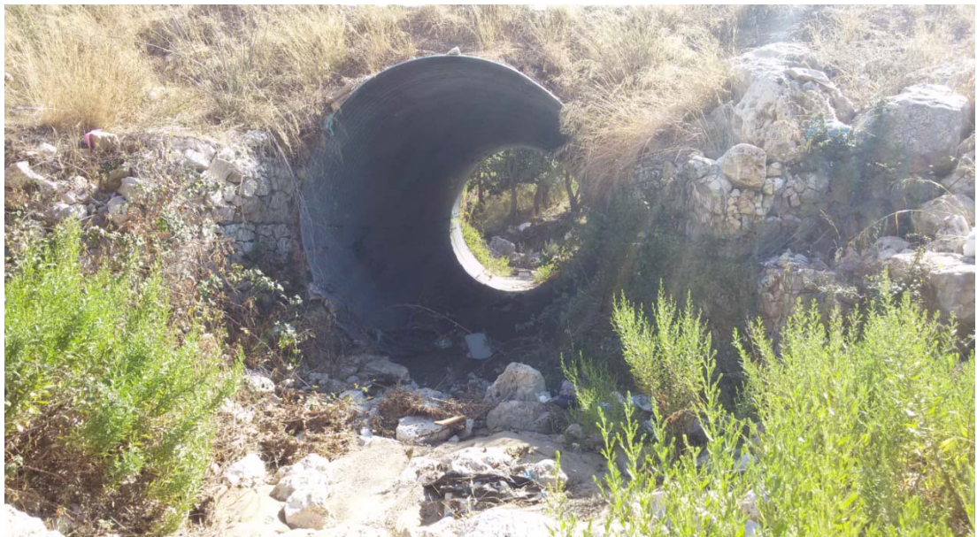
Fig. 4.7: Vista da monte dell'interferenza di via Palombaro
