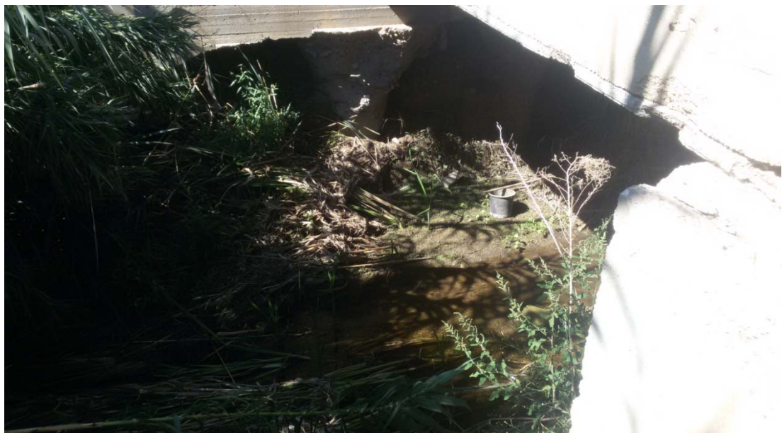
Fig. 4.48: Vista da valle dell'attraversamento Lognone - Monte Confluenza
