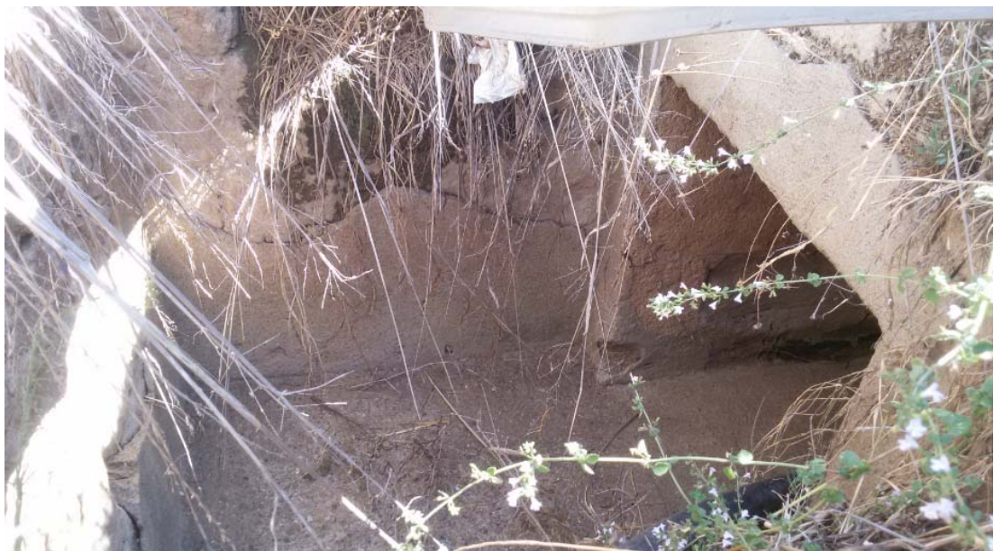
Fig. 4.27: Vista da monte dell'interferenza Ponte Secondario SP2
