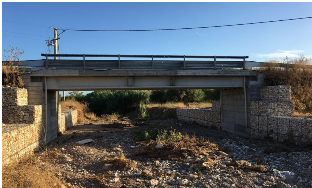
Fig. 4.46: Vista da monte dell'interferenza con la EX SS SS580
