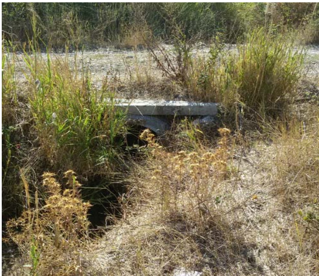
Fig. 4.8: Vista da valle del tombino idraulico secondario DN800
