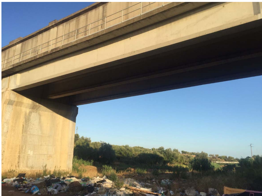
Fig. 4.31: Foto delle pile del canale dell'EIPLI
