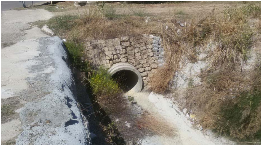
Fig. 4.18: Vista da valle dell'interferenza SP1-Zona Campagna
