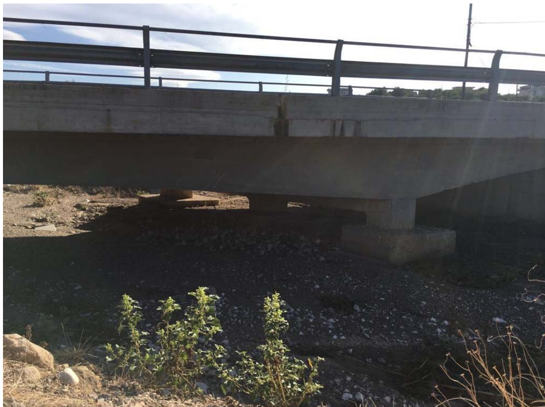
Fig. 4.41: Vista da monte dell'interferenza Ponte SP8
