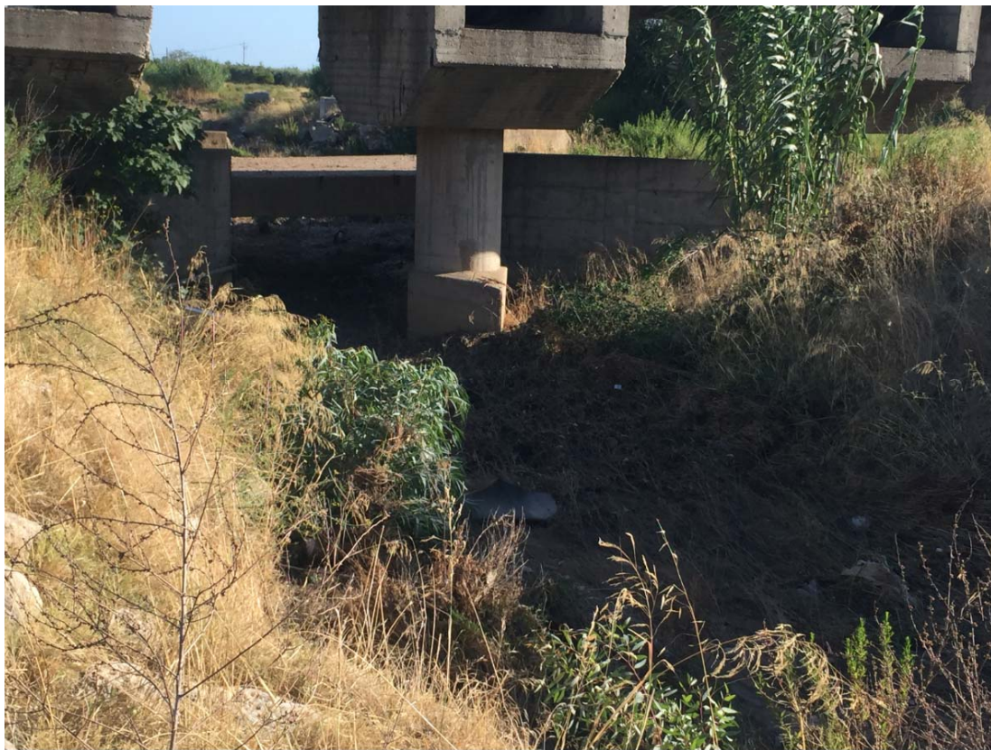
Fig. 4.43: Vista da monte dell'interferenza Acquedotto Sinni-Pertusillo e canale EIPLI
