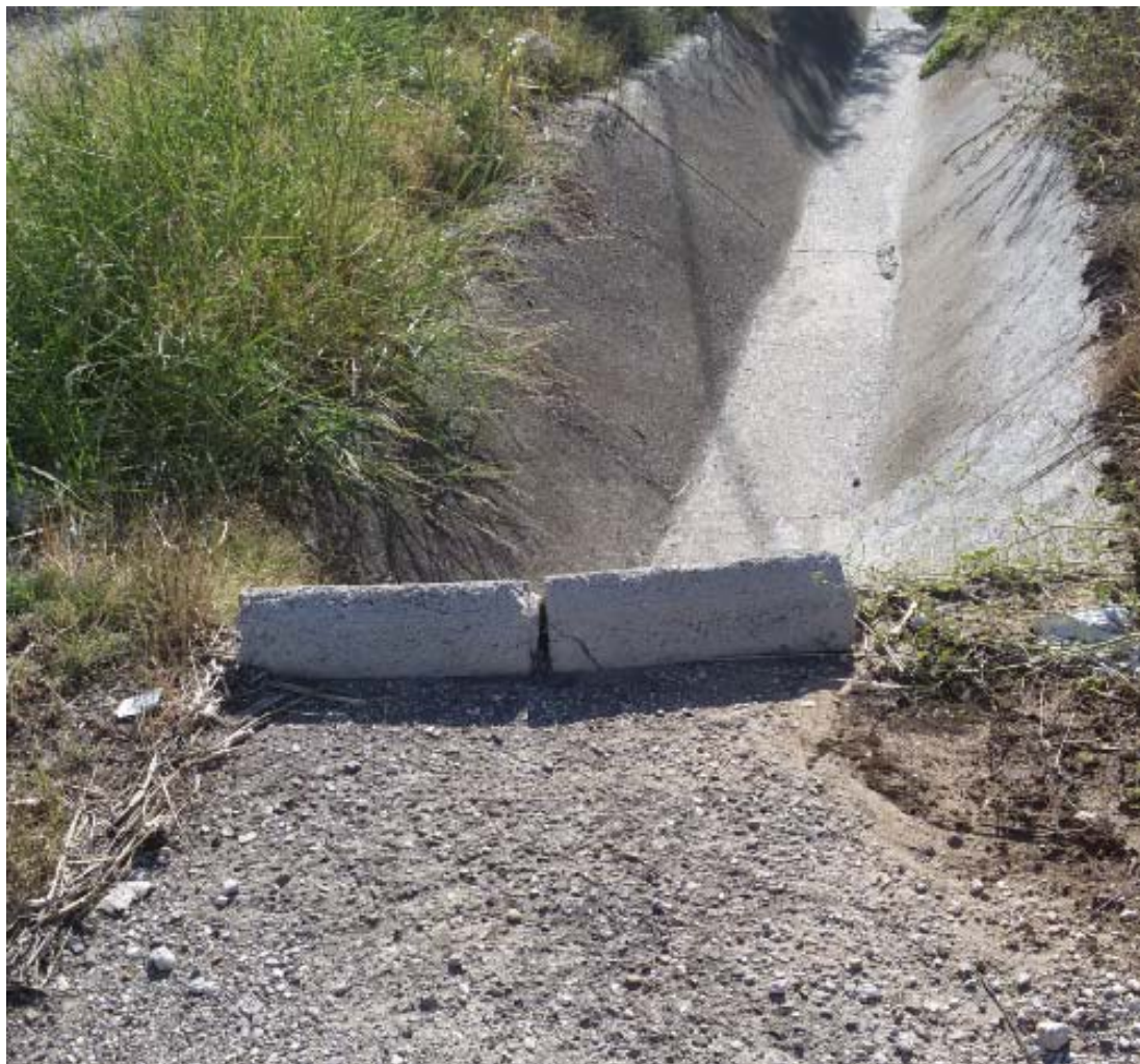
Fig. 4.16: Vista da monte del canale che confluisce a monte dell'attraversamento Ponte SP1 – Campo Sportivo
