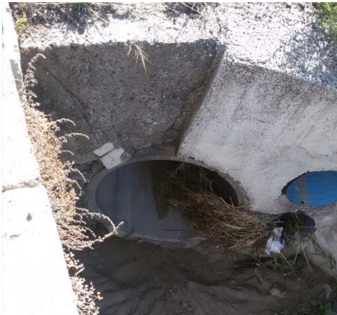
Fig. 4.13: Vista da monte del tratto iniziale del Canale Via Cignano
