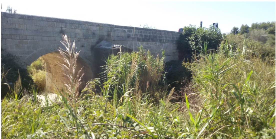
Fig. 4.25: Vista da monte dell'interferenza Ponte SP2
