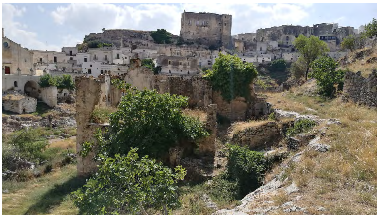
Scala di collegamento all'interno di un fabbricato esistente
