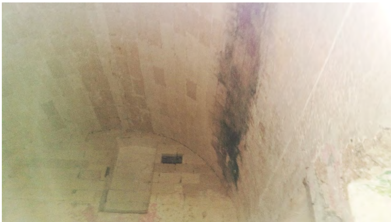
Dettaglio interno della volta a botte
