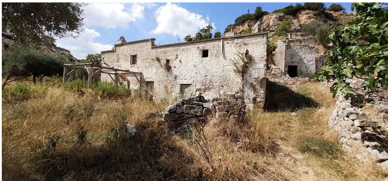
Esterno del fabbricato da recuperare
