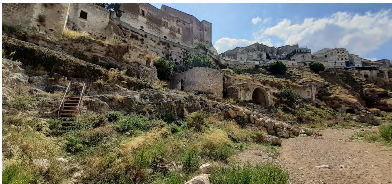
Scala di collegamento tra alveo e accesso da Via Matrice
