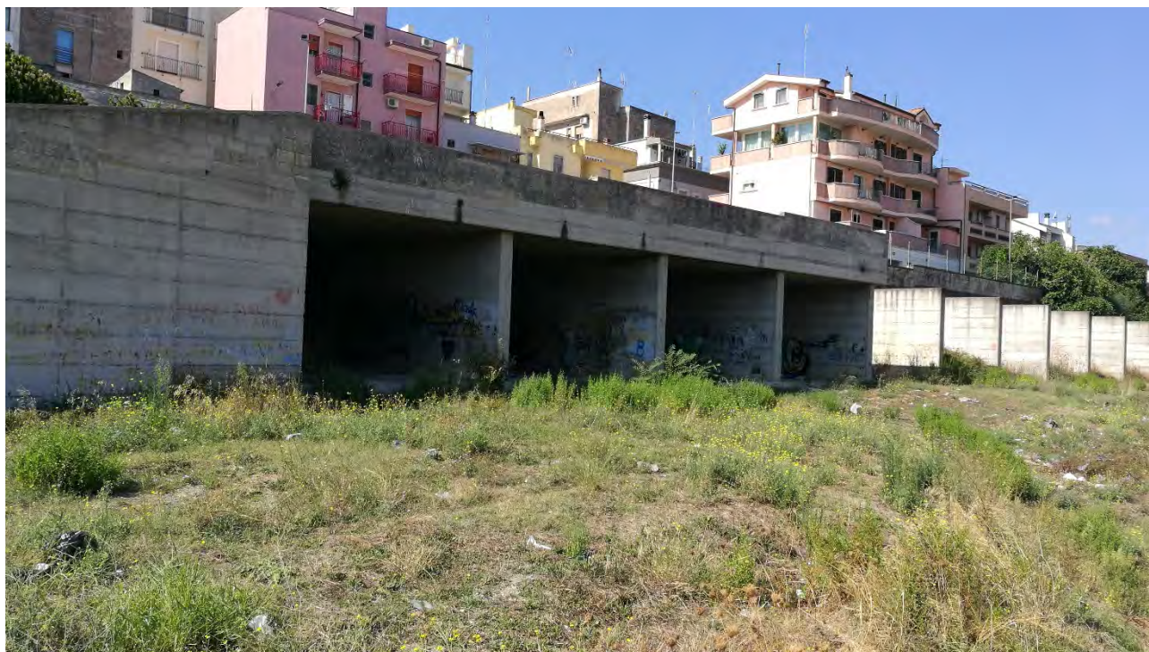
Setti di sostegno di Via Manzoni
