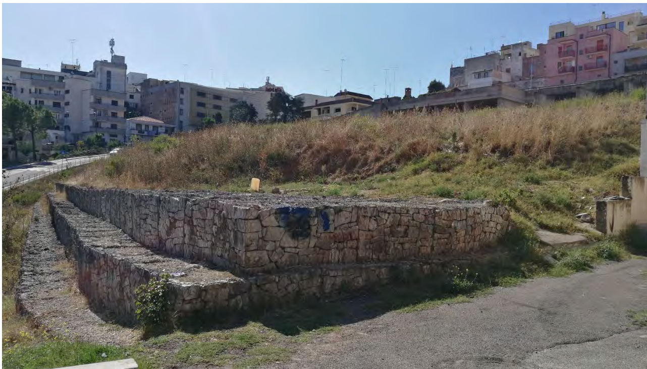
Gabbionate di consolidamento del pendio
