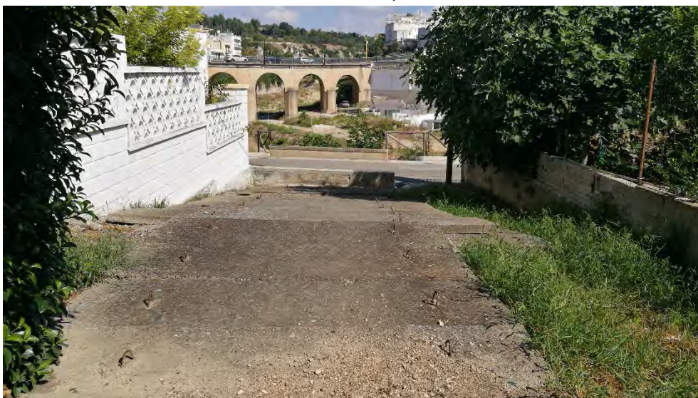
Lastre in cls di copertura al canale
