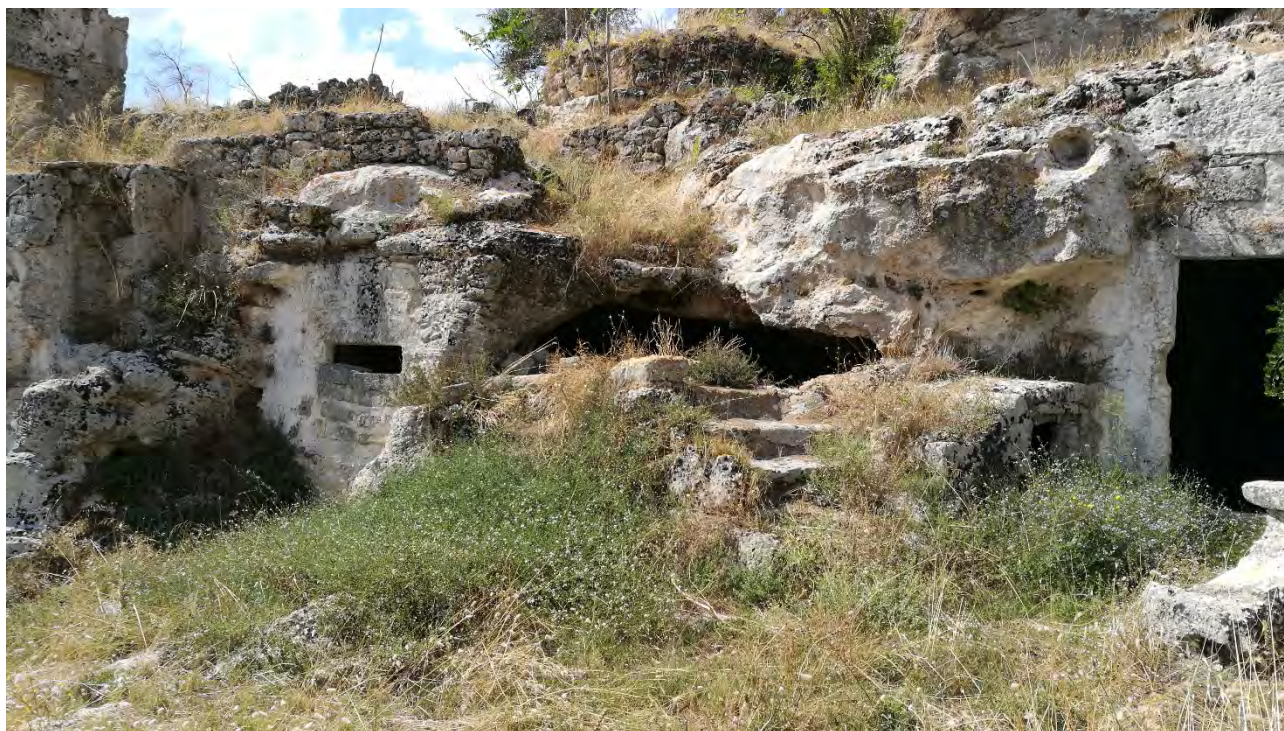
Scala di collegamento tra i due livelli del percorso
