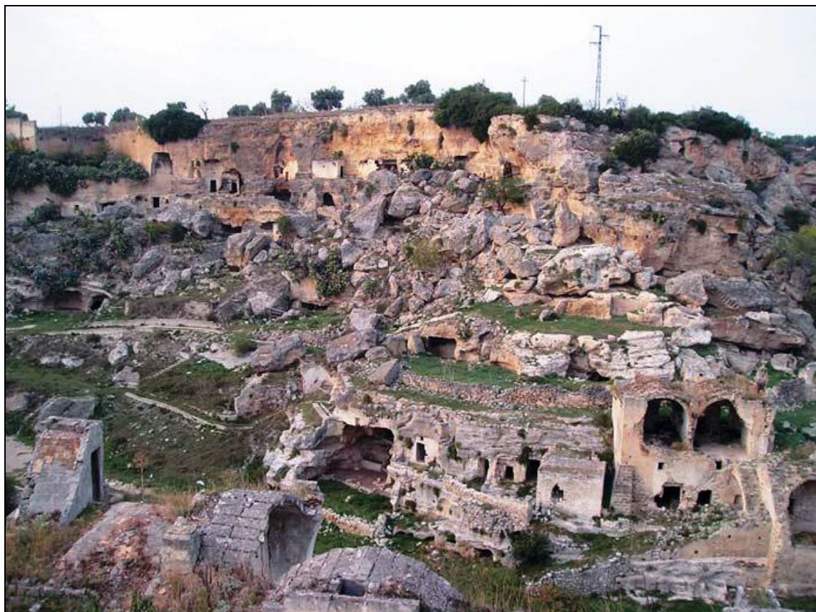
Fig. 16: Sponda sinistra della gravina di Ginosa, il Casale. Crollo del 1857 (sito N in fig.21)
