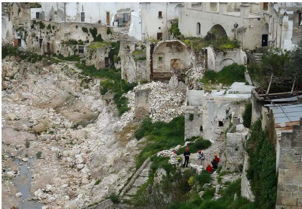
Fig. 29: Rudere crollato nei pressi della Chiesa Matrice (sito E in fig.21)
