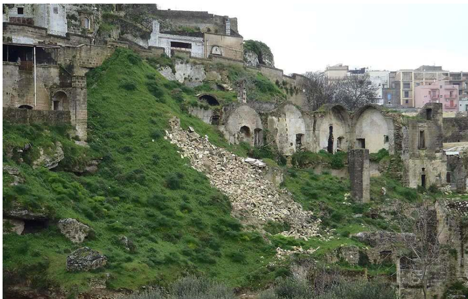
Fig. 24: Rudere crollato a valle di Via Matrice (Rapporto CNR-IRPI 2014)
