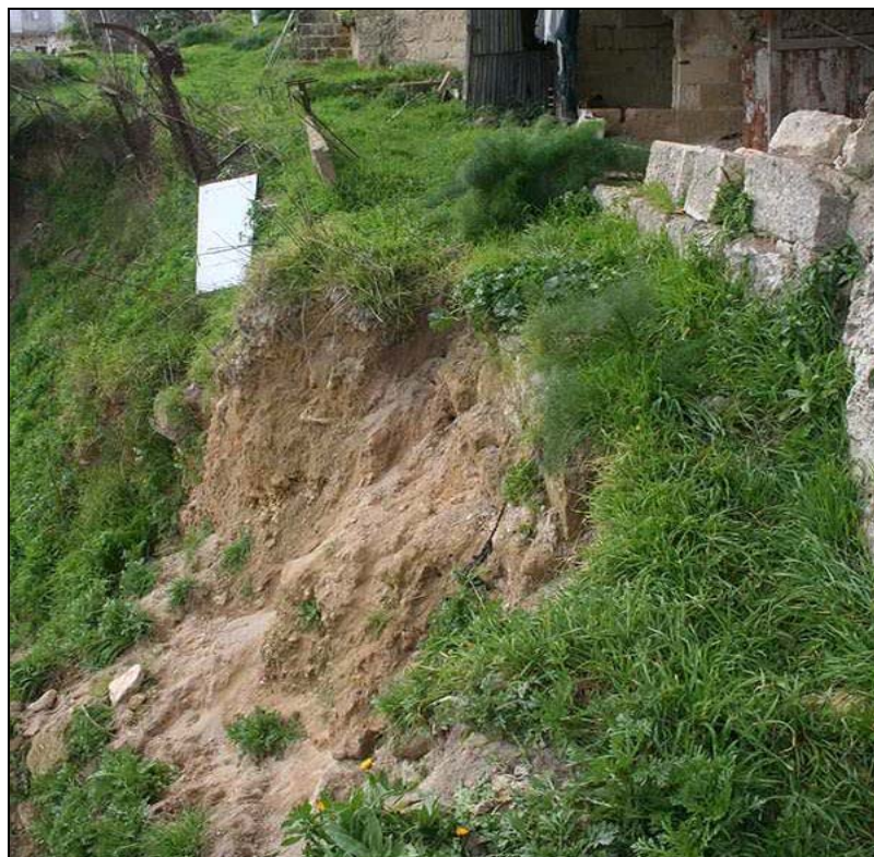
Fig. 25: Scorrimento rotazionale sul pianoro del Castello (Rapporto CNR-IRPI 2014)
