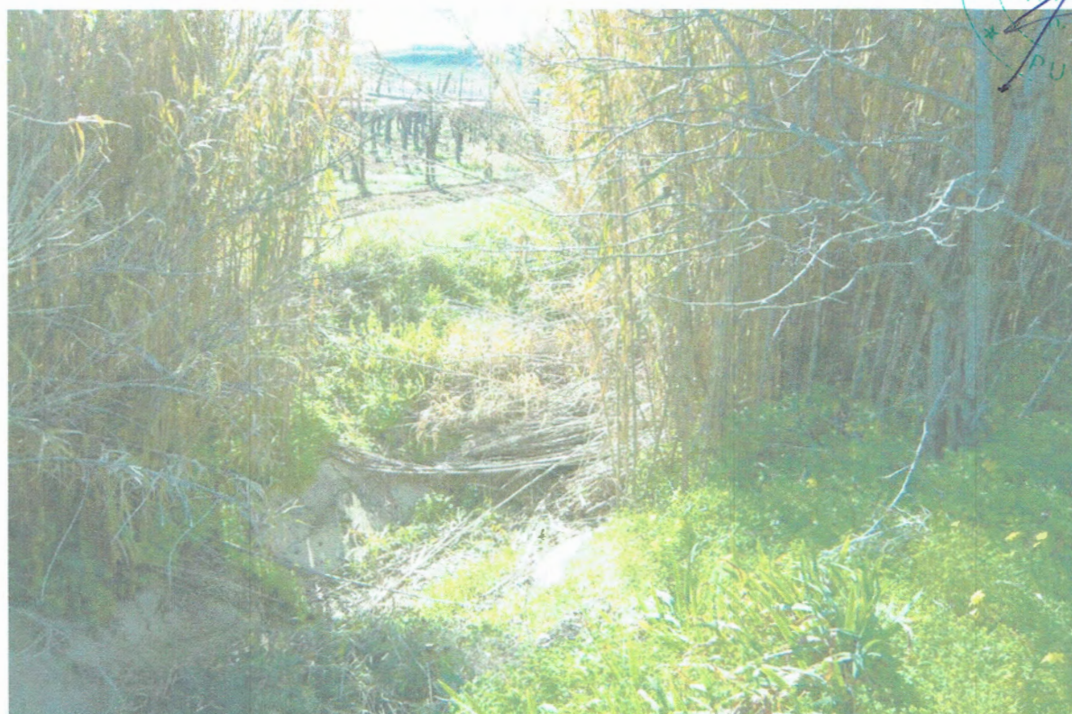
Foto 6.d – Vista del tratto di canale impermeabilizzato a valle nei pressi della sezione 3.
