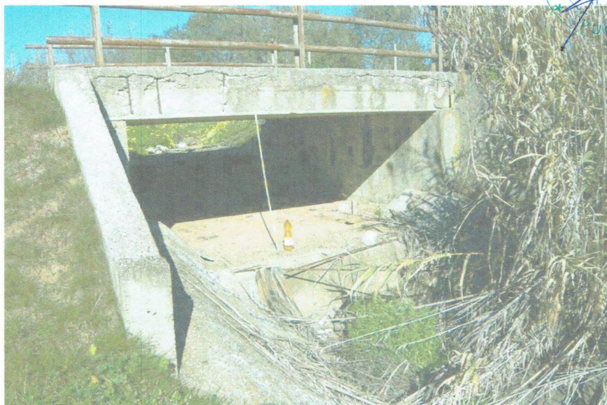
Foto 6.b – Vista verso Nord a pochi metri dalla sezione 8, si nota il canale interamente rivestito.
